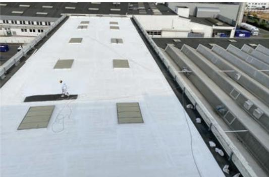
■ L'application d'un revêtement réfléchissant sur 3 000m<sup>2</sup> de toiture bitumée entre juin et juillet contribue également à la maîtrise de la consommation du groupe froid, et donc de la climatisation des bureaux et logistique, tout en renforçant le confort des salariés.
